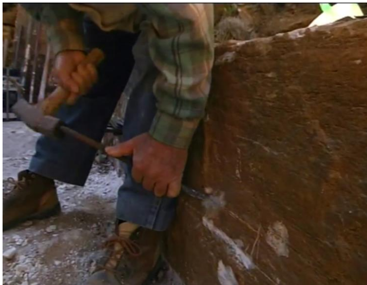
Εικόνα 52: Εργασία εξόρυξης στο λατομείο
