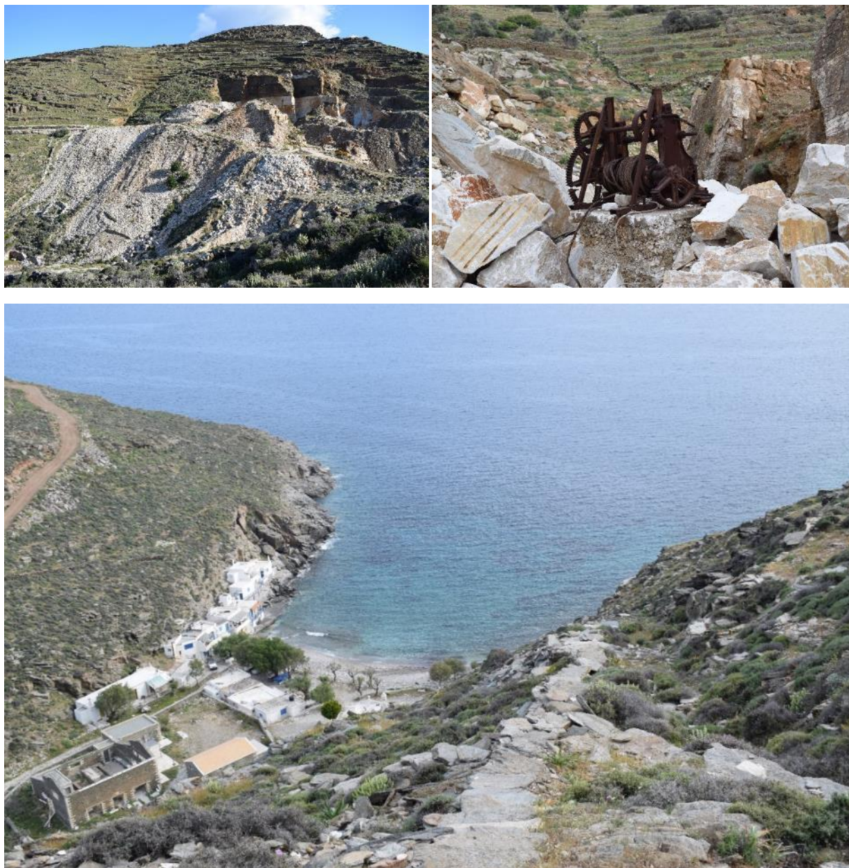
Εικόνα 10. Επάνω αριστερά: σημερινή άποψη του λατομείου από το χωμάτινο δρόμο, δεξιά: βίντσι για την έλξη βαγονέτου. Κάτω: άποψη, από τα δυτικά, των εγκαταστάσεων σήμερα (μηχανοστάσιο, σχιστήριο, οίκημα διαμονής προσωπικού).
